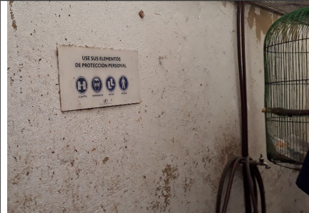
Foto 39. Zona de Rehabilitación física A. Detalle de Señalización para el uso de los elementos de protección personal y punto de agua potable.
