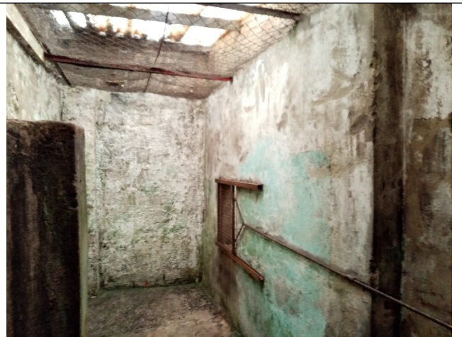
Foto 42. Zona de Rehabilitación física B. Detalle de las características de los encierros ubicados en esta zona.
